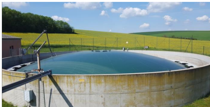
Figure 24. Photo de l'installation Nénufar sur l'unité Multiporc de l'Aire (élevage porcin, valorisation chaudière). Source Nénufar.
