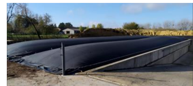
Figure 31: Photographie du Enerpente (source Enerpro)
