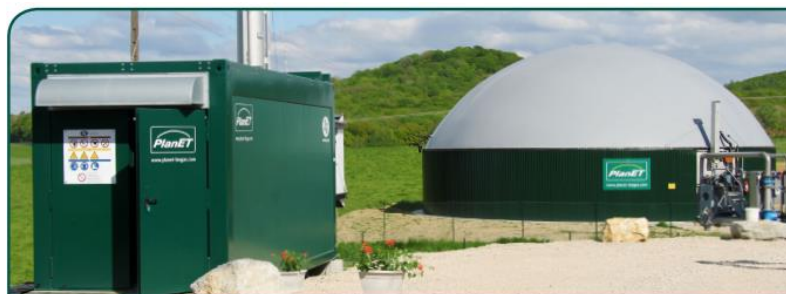
Figure 25. Photo de l'installation PlanET à la SARL Novalait [61]
