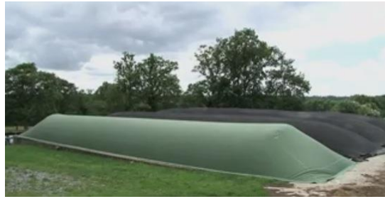
Figure 35. Photo de l'installation du GAEC du Bois Joly [72]
