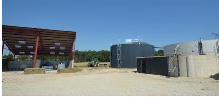
Figure 33. Photo de l'installation du GAEC des Trois Communes [73]
