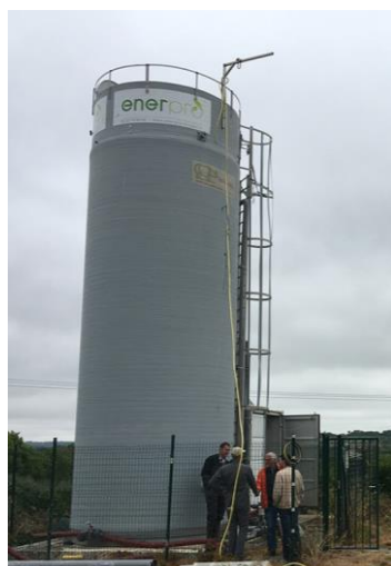
Figure 32. "Silo tour" Enerpro Biogaz à la Ferme de Bel Air
